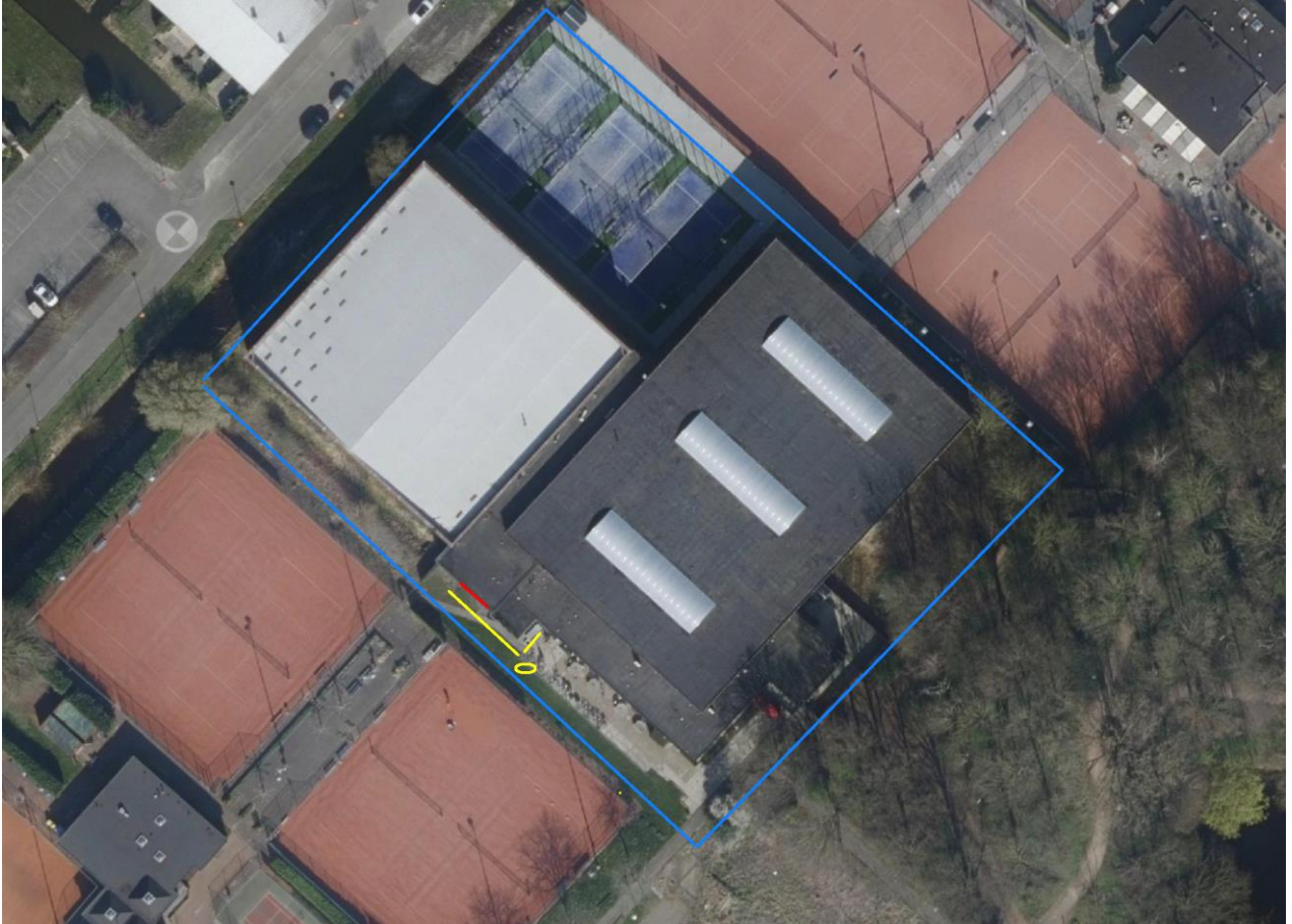
Afbeelding 1: Plangebied (blauwe kader). De rode streep geeft de positie van de vier open stootvoegen weer. De gele cirkel de positie van de onderzoeker en de gele lijnen de zichtlijnen van de onderzoeker.
