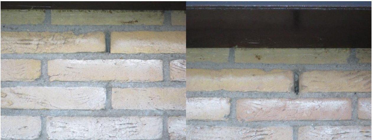
Afbeelding 3: alle vier de open stootvoegen in het plangebied zitten vol met spinrag / cementresten.
