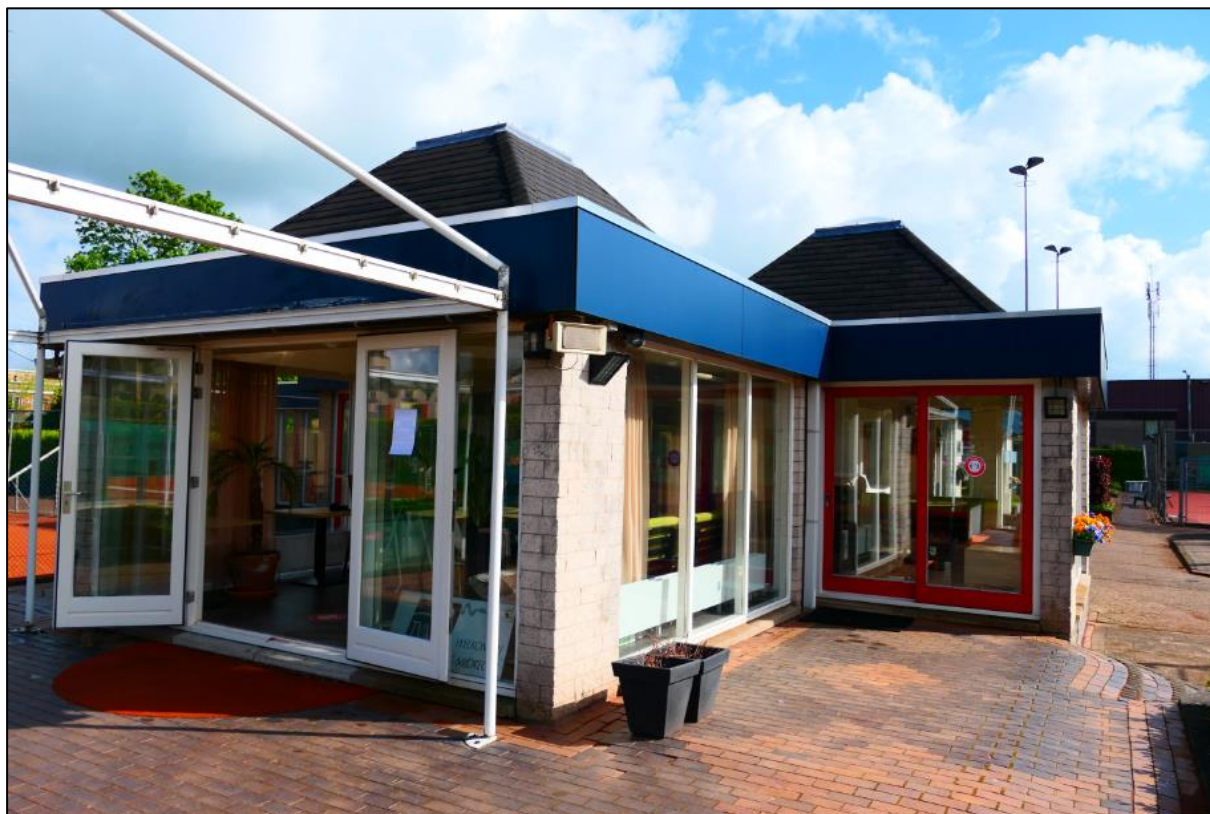
Figuur 1.5 Kantine / verenigingsgebouw TVM, gezien vanuit westelijke richting.
