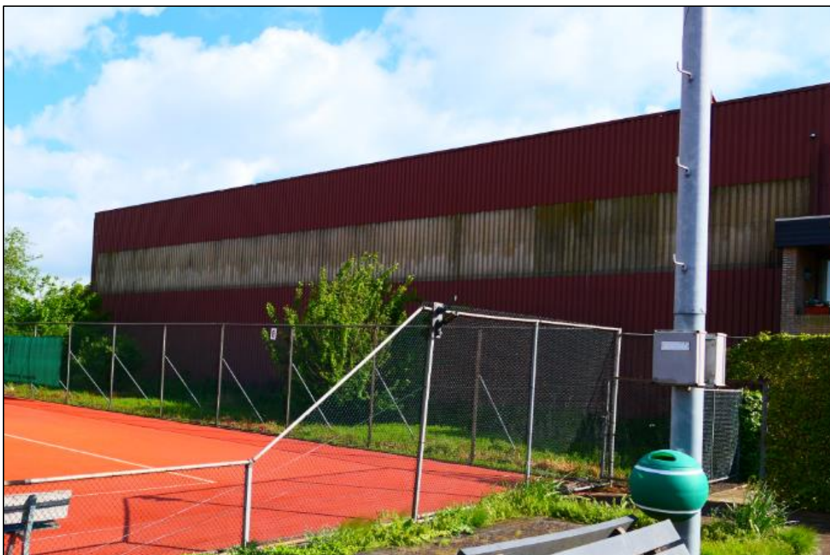
Figuur 1.8 Overzichtsfoto van de tennishal, gezien vanuit westelijke richting.
