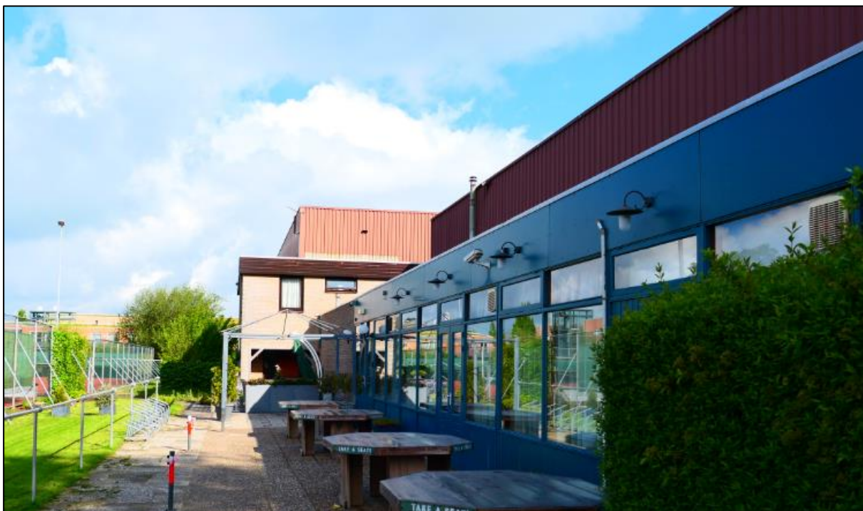
Figuur 1.7 Overzichtsfoto kantine en tennishal, gezien vanuit zuidwestelijke richting.
