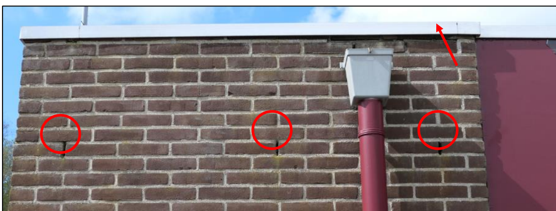
Figuur 4.7 Potentieel geschikte vliegopeningen voor vleermuizen in pand TVDRV (locatie 3).
