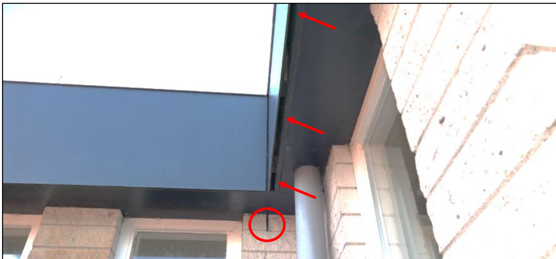
Figuur 4.4 Potentieel geschikte vliegopeningen voor vleermuizen in het TVM pand (locatie 1).
