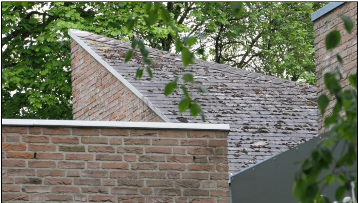
Figuur 4.1 Puntig en vlak dak op de achtergrond en op de voorground deels plat dak.
