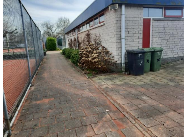
Foto 8: Pad tussen het clubpand en de noordwestelijk tennisbaan.
