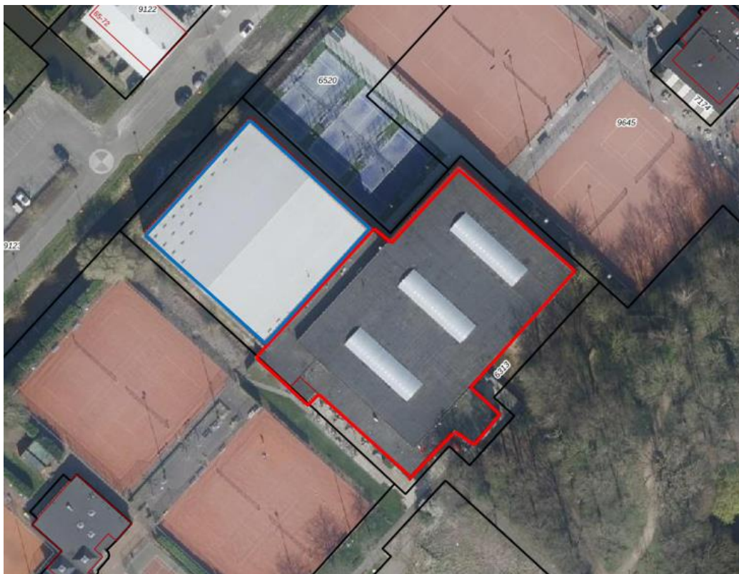
Figuur 1: rood omlijnd asfalt/bitumen (circa 2.460 m 2 ), blauw omlijnd schuimbeton (circa 1.260 m 2 ).
