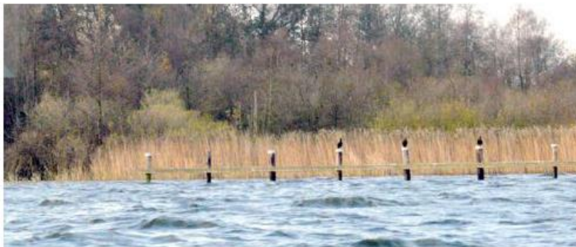
Figuur 5-7: Aanlegvoorziening voor natuurvriendelijke oever (Arcadis, 2020).
