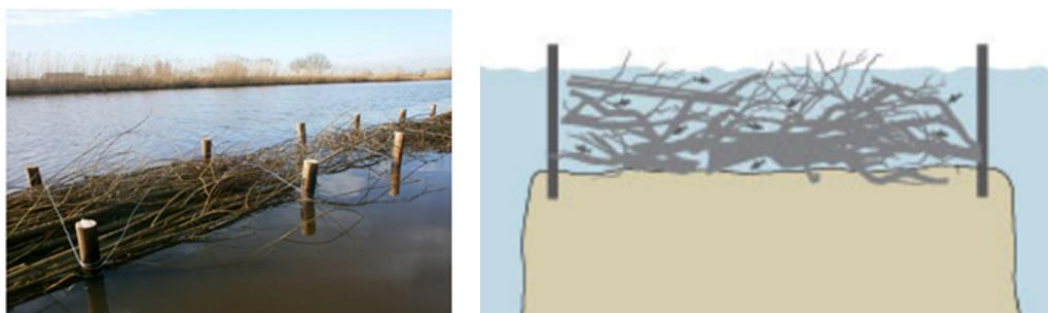
Figuur 2.4: Voorbeelden van vissenbossen op verzonken legakkers. Beide figuren zijn afkomstig uit Van Helsdingen & Buizer, 2018. Links is een foto van een vissenbos (figuur 4.9 uit voorgenoemde rapport). Rechts geeft een schematische dwarsdoorsnede (Kos, 2022).
