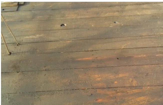
toelichting foto: schone vloer
