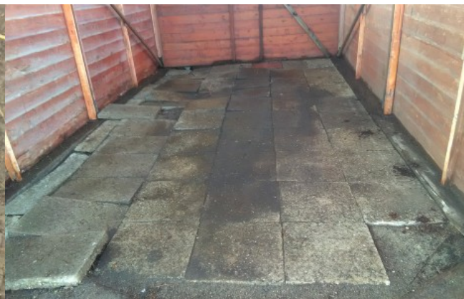
toelichting foto: schone vloer
