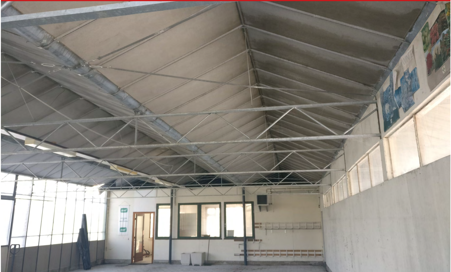
Beeldimpressie: te slopen opslaggebouw
