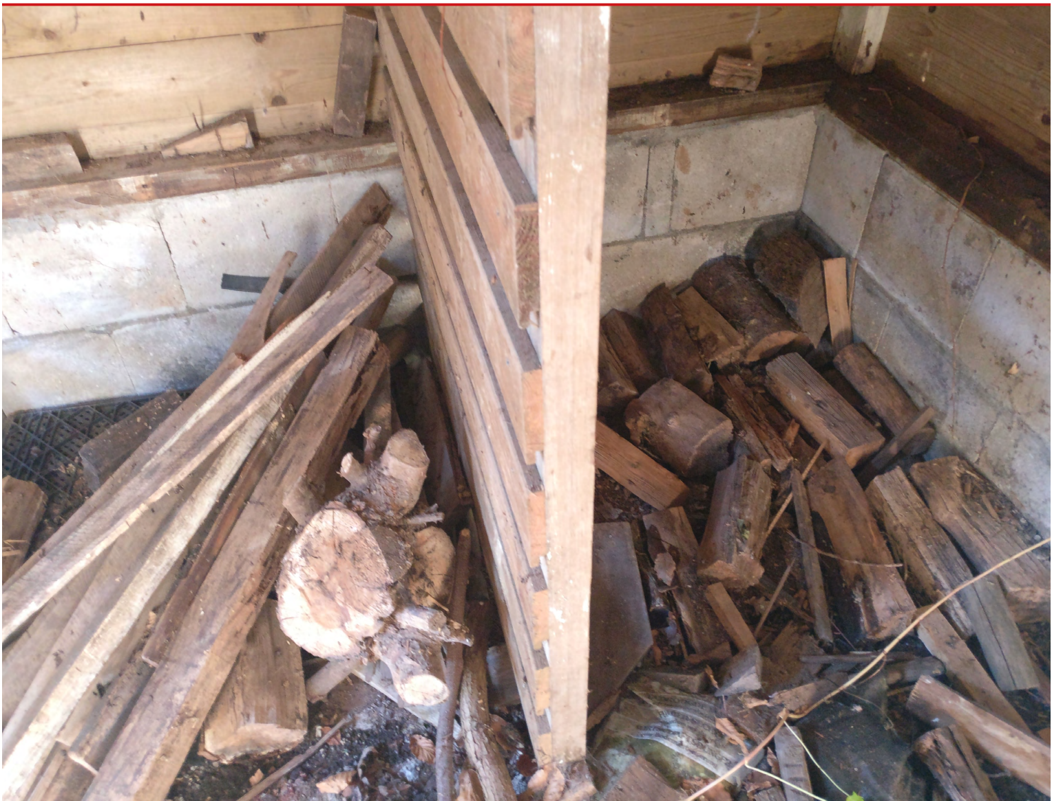
Beeldimpressie: binnenkant te slopen tuinhuisje
