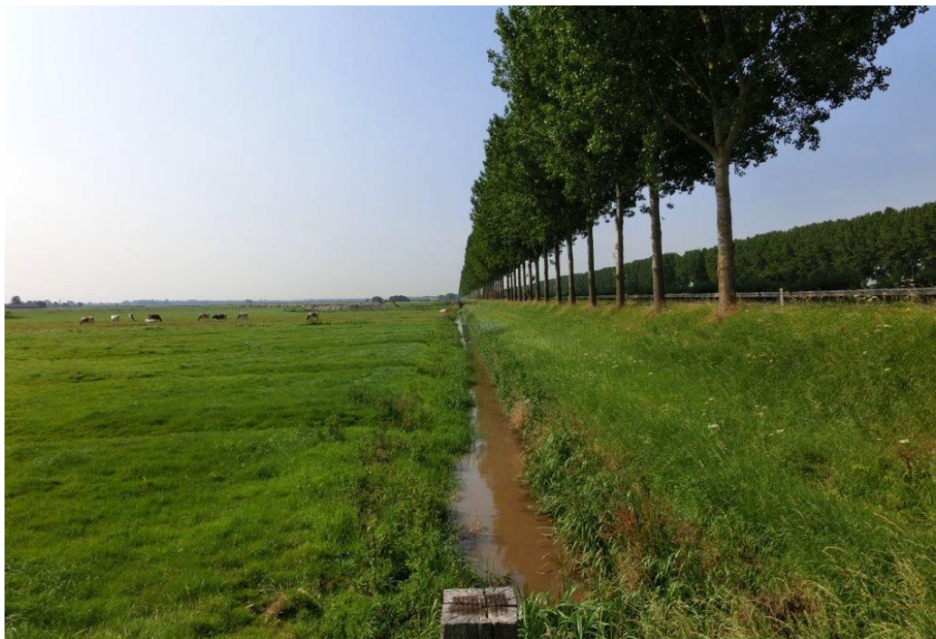
Figuur 3.2 Talud langs Hoekerpolder onder Betonfabriek Nigtevecht met enkele populierenrij.
