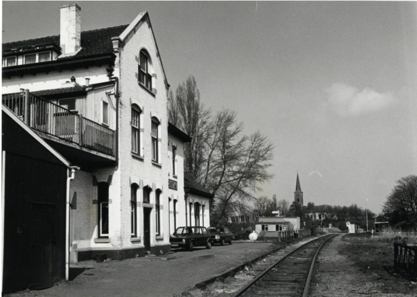
Spoorzijde van het station bij firma Koek, jaren 70 (collectie RHCVV M677)
