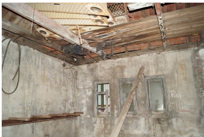
Interieur, bergruimte zuidzijde
