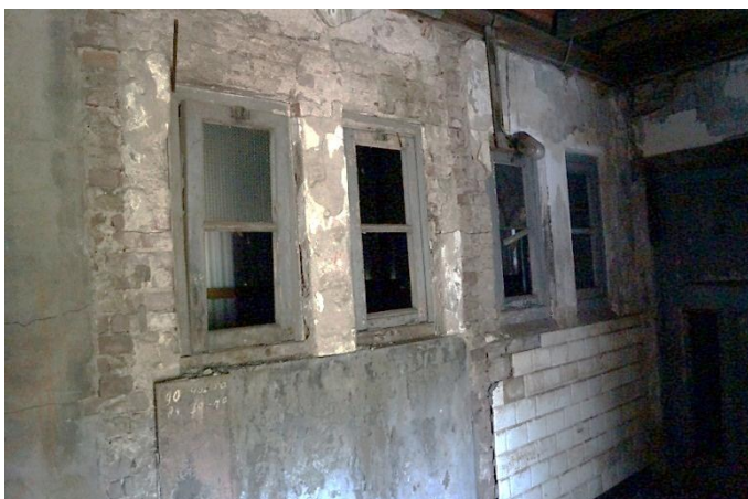
Westgevel vanuit het interieur 2012
