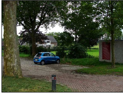
Foto 3. Parkeerplaats en transformatorhuisje
