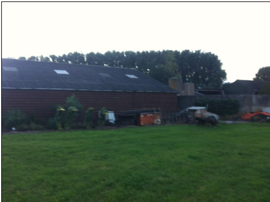
Figuur 2: de schuren in het plangebied zijn vanwege de houten muren en het golfplaten dak ongeschikt als verblijfplaats voor vleermuizen (slecht microklimaat).
