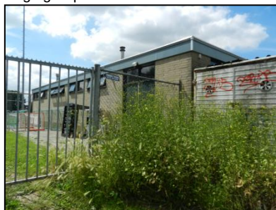
Figuur 7. Muur, oostelijke gevel clubgebouw.
