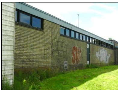
Figuur 6. Muur, noordelijke gevel clubgebouw.
