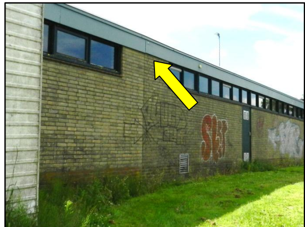
Figuur 4. Foto van noordelijke muur van het clubgebouw voetbalvereniging Asperen met locatie verblijfplaats van de gewone dwergvleermuis.
