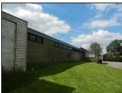
Figuur 6. Muur, noordelijke gevel clubgebouw.
