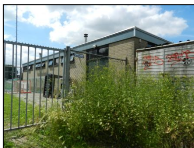
Figuur 7. Muur, oostelijke gevel clubgebouw.
