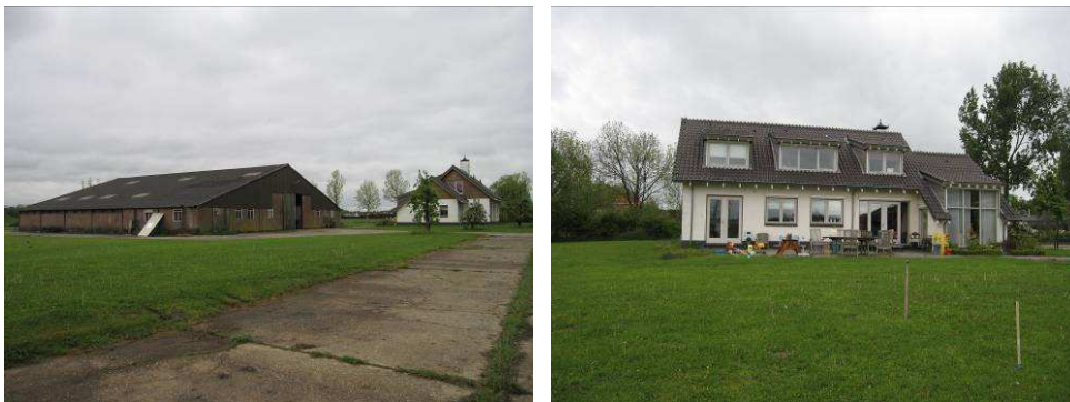
De stal en het woonhuis gelegen aan de Spijkse Kweldijk 41
