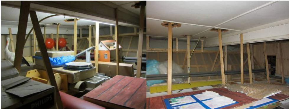
Figuur 10. Kruipzolder in het schoolgebouw met gaten die toegang geven tot een ruimte tussen het plafond en het dak.
