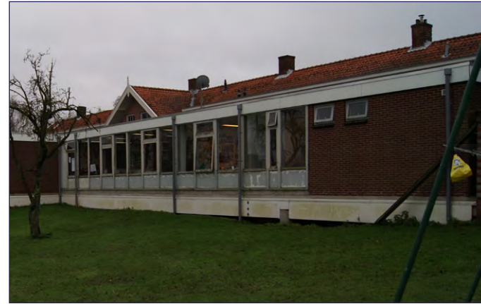
Het kantoor wordt afgebroken, de historische huizen komen in het zicht
