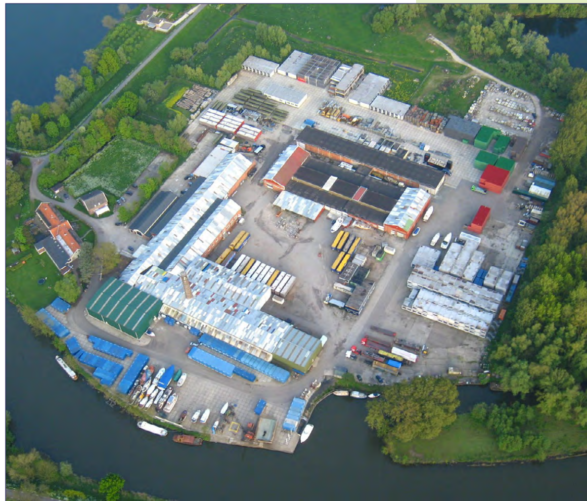
Luchtfoto van de huidige situatie
