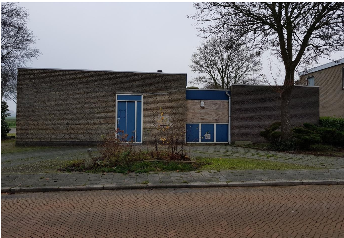
Foto: gevel kantoorpand aan Molenstraat
