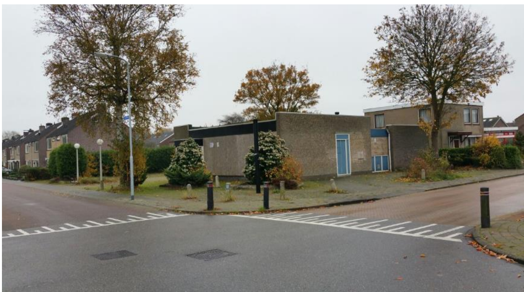
Afbeelding 4: foto bestaande situatie vanaf noordwestzijde
