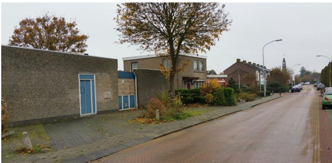
Afbeelding 5: foto bestaande situatie vanaf westzijde
