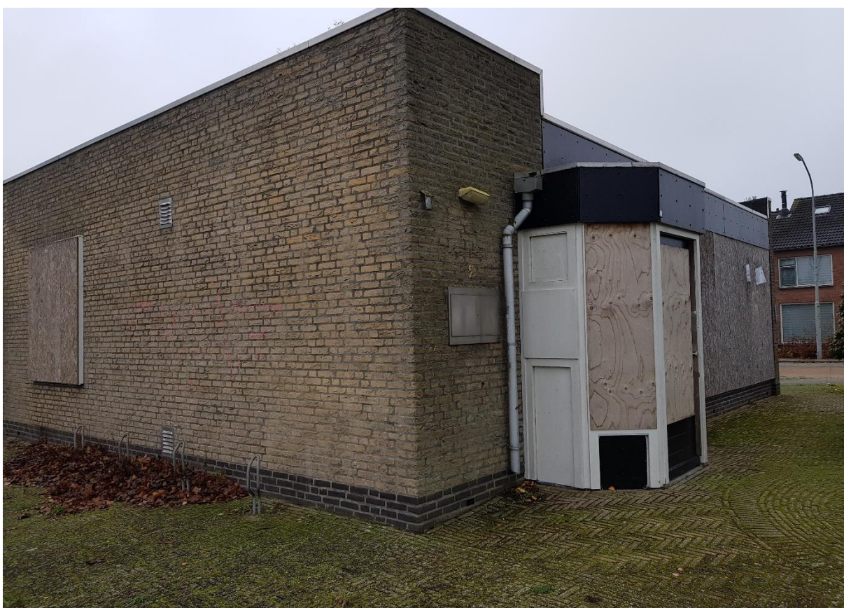
Gevel kantoorpand aan de Vinkenlaanzijde
