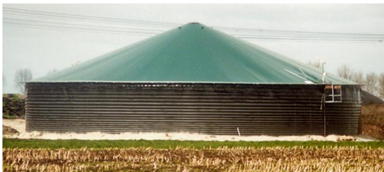
Figuur 3: Voorbeeld mestsilo
