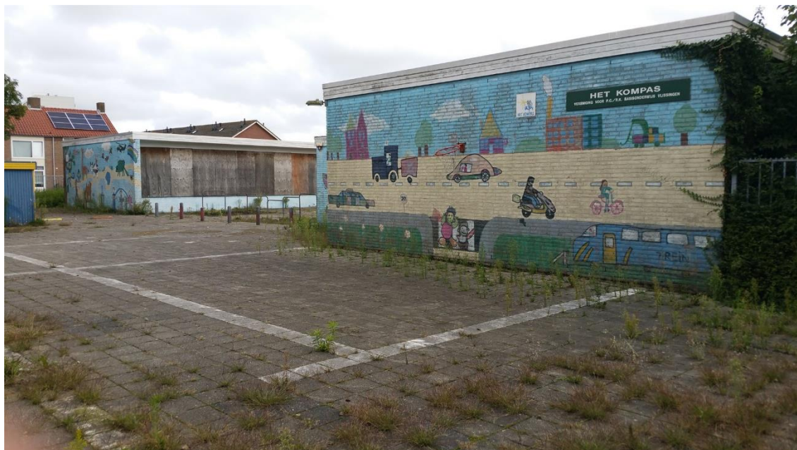
Figuur 5. Overzicht schoolplein met bebouwing
