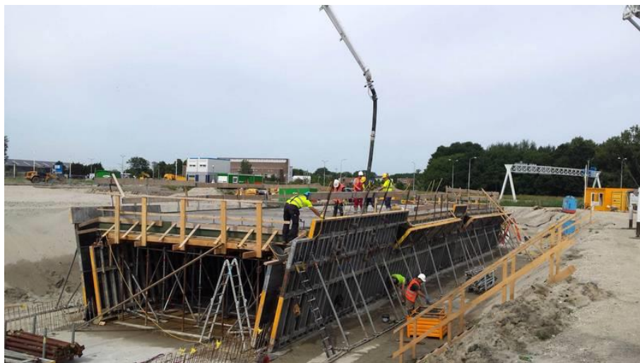
Figuur 19 Fietstunnel in aanbouw
