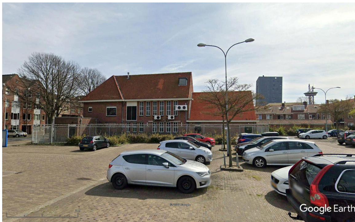
Figuur 3.3: Streetview op KPN-gebouw vanaf de noordzijde genomen.
