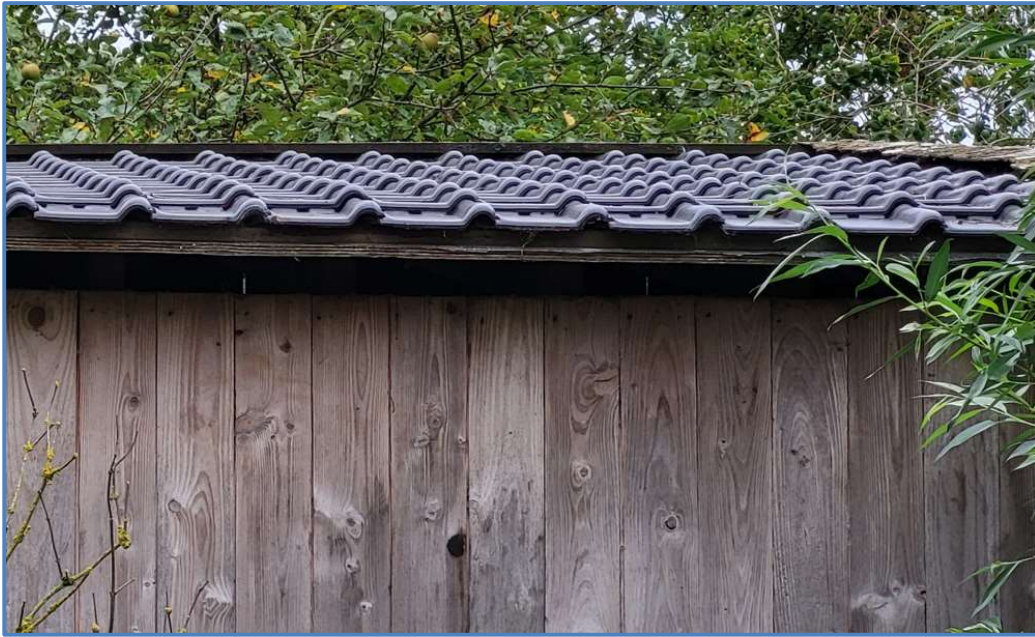
Het pannendak van de af te breken berging is ontoegankelijk voor vleermuizen en huismussen.
