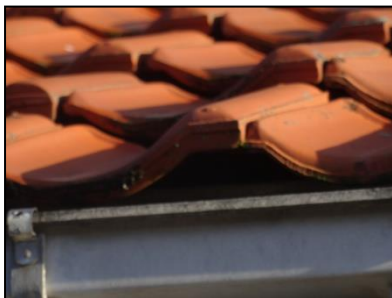
Figuur 9. Ruimte onder dakpannen bij de bebouwing op de onderzoekslocatie.
