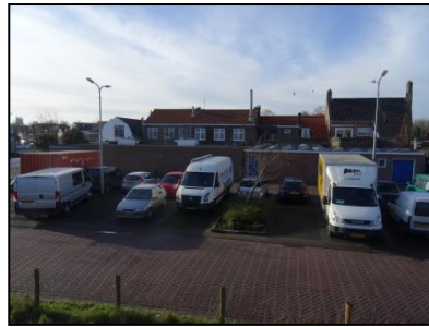
Figuur 7. Aanzicht op de oostzijde van de bebouwing op de onderzoekslocatie, vanaf de grondwal rondom de naastgelegen burcht.
