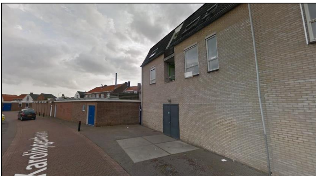
Figuur 4. Foto's bestaande situatie aan de zijde van de Vlissingsestraat en de Karolingenbaan (Bron: Google)
