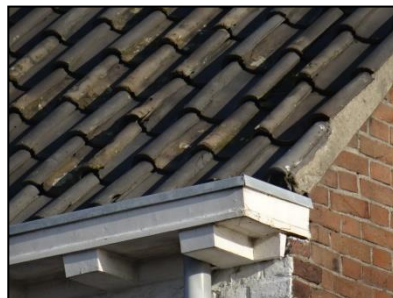
Figuur 10. Ruimte onder de dakpannen bij de bebouwing op de onderzoekslocatie.
