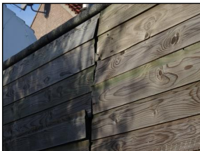
Figuur 12. Ruimte achter betimmering door scheve planken in de zuidoostelijke hoek van de onderzoekslocatie.
