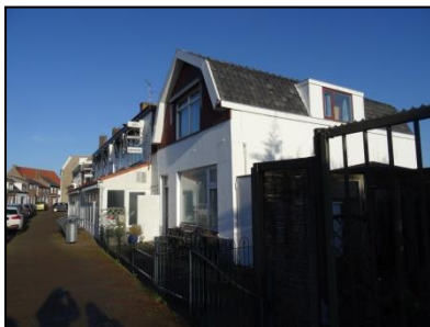
Figuur 3. Noordelijke kijkrichting vanuit de zuidwestelijke hoek van de onderzoekslocatie.
