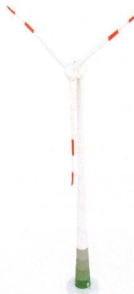
Figuur 4.9. technische gegevens Enercon 126 en een beeld van de windturbine. (n.b. de rode vlakken op de wieken zijn in Duistland verplicht niet in Nederland)
