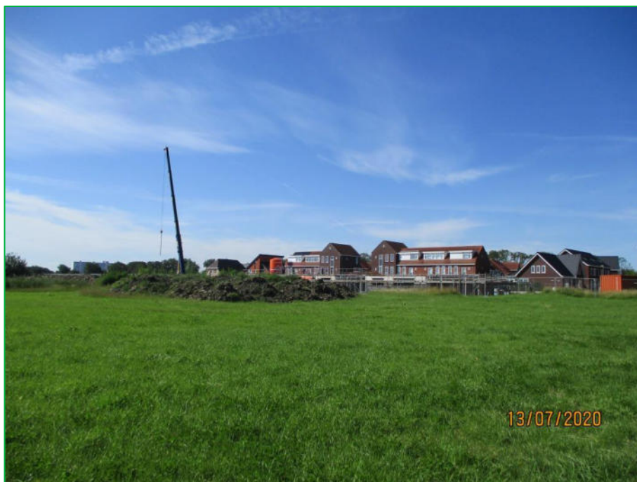
Foto 1: Noordelijk terrein richting woonwijk in aanbouw
