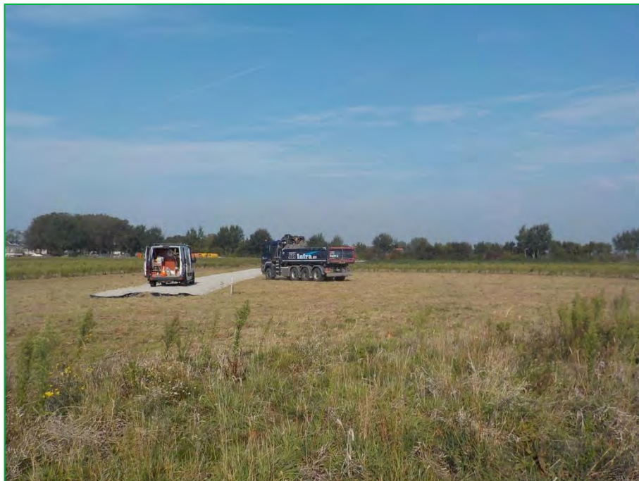
Foto 3. Tijdens het veldwerk werd een werkweg aangelegd.
