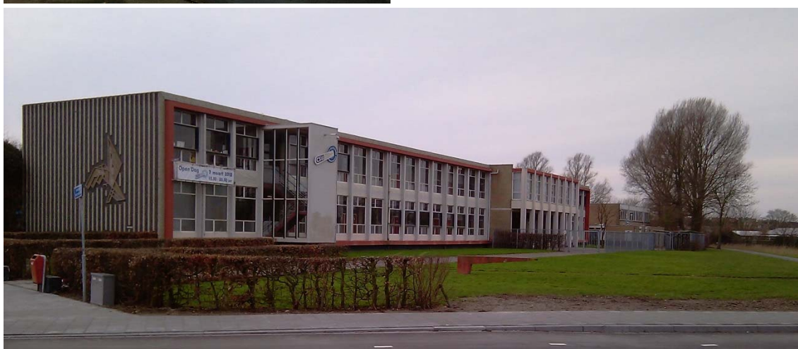
Afbeelding 4: Impressie van de in het plangebied aanwezige bebouwing.
