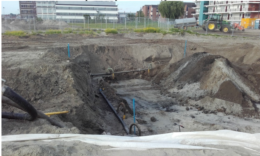
Foto 17. Ontgraving oliespot met voorraad grond 24 juni 2019
