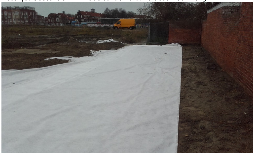
Foto 46. Geotextiel vml rode schuur d.d. 16 december 2019
