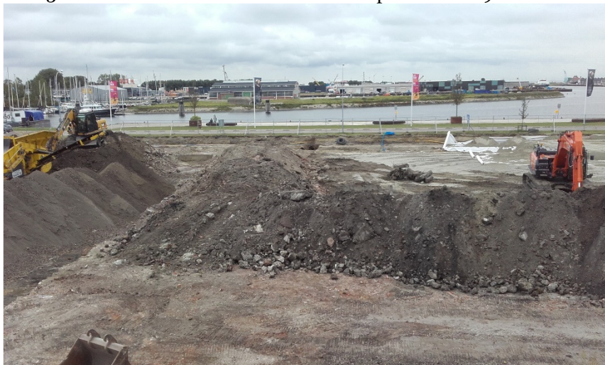
Foto 33. Vrijgekomen schoon puin bouwblok E 20 september 2019
