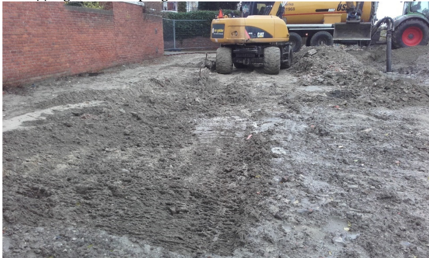
Foto 45. Aanbrengen schone grond vml rode schuur d.d. 16 december 2019
