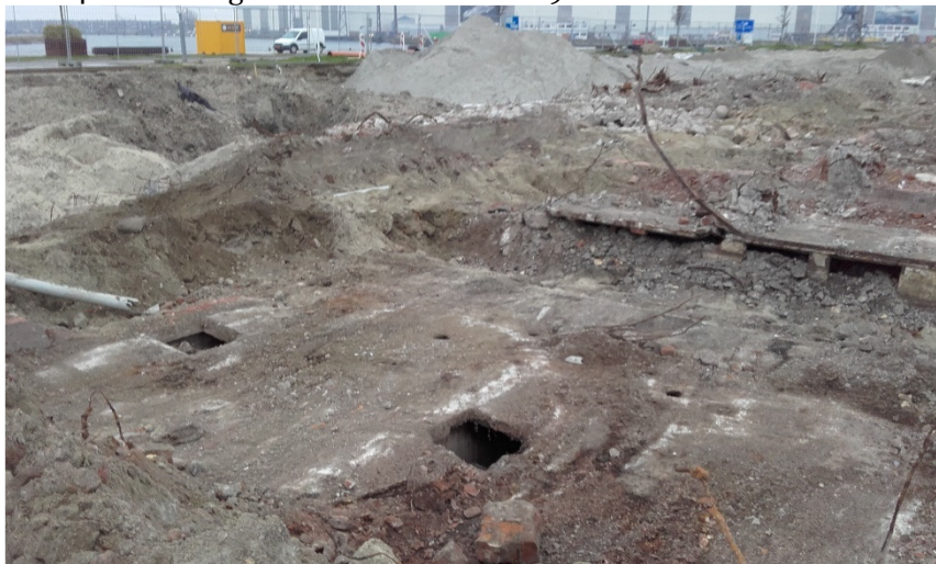
Foto 42. Asphalt op de Kota Baroestraat 20 november 2019
