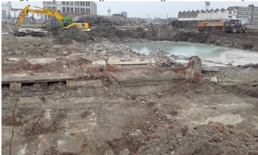
Foto 34. Verwijderen ondergrondse funderingsresten 1 oktober 2019
