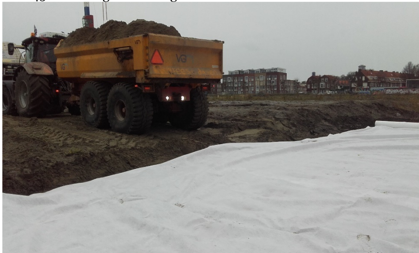
Foto 46. Geotextiel vml rode schuur d.d. 16 december 2019
