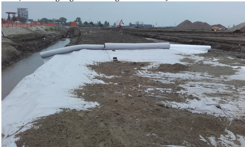
Foto 8. Aanbrengen geotextiel en zand 'De Vesting' 21 mei 2019
