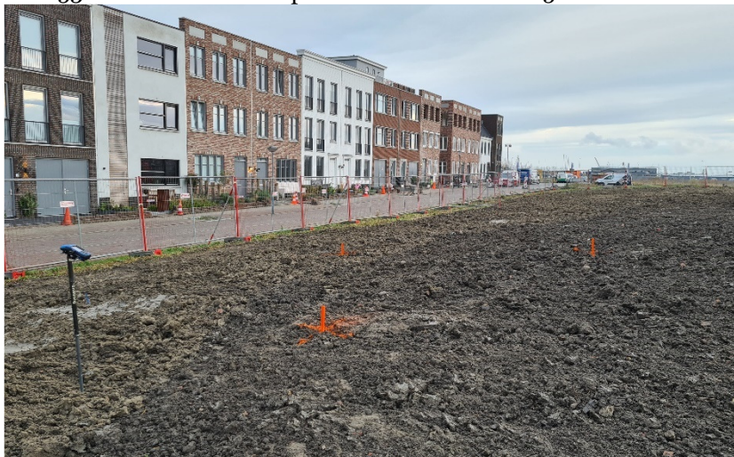
Foto 54. Start ontgraving grond uit zoutwaterbassin november 2021
