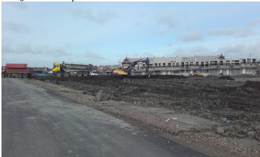
Foto 51. Situatie park en nieuwbouw Vesting februari 2020
