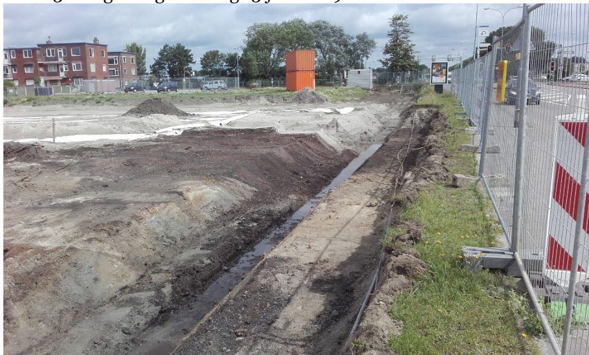
Foto 14. Aanbrengen schone grond bouwblok A 18 juni 2019
