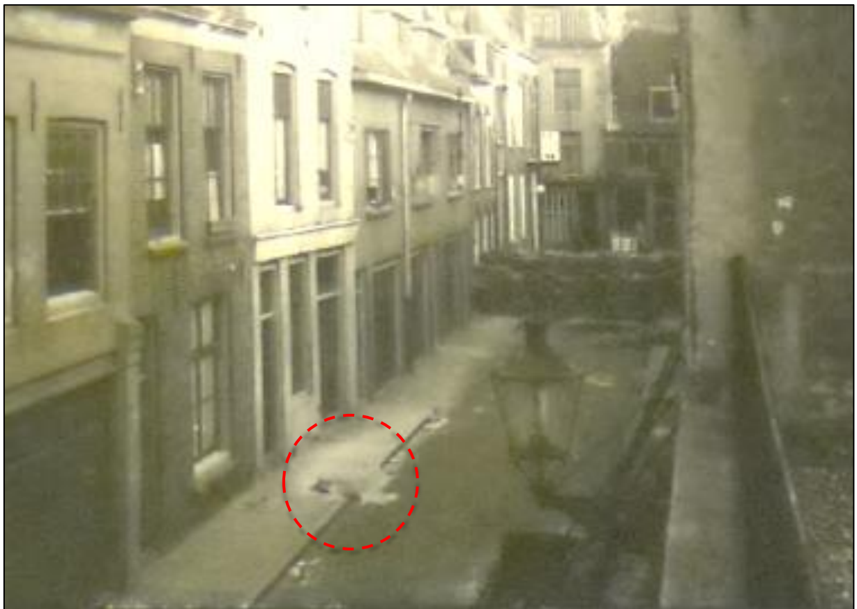
Figuur 49: Effect van de inslag van een blindganger (Inslagopening) 50
