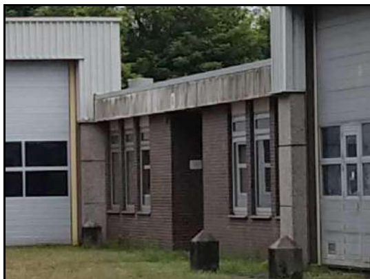
Afbeelding 4: Bebouwing met ruimte achter boeiboord
