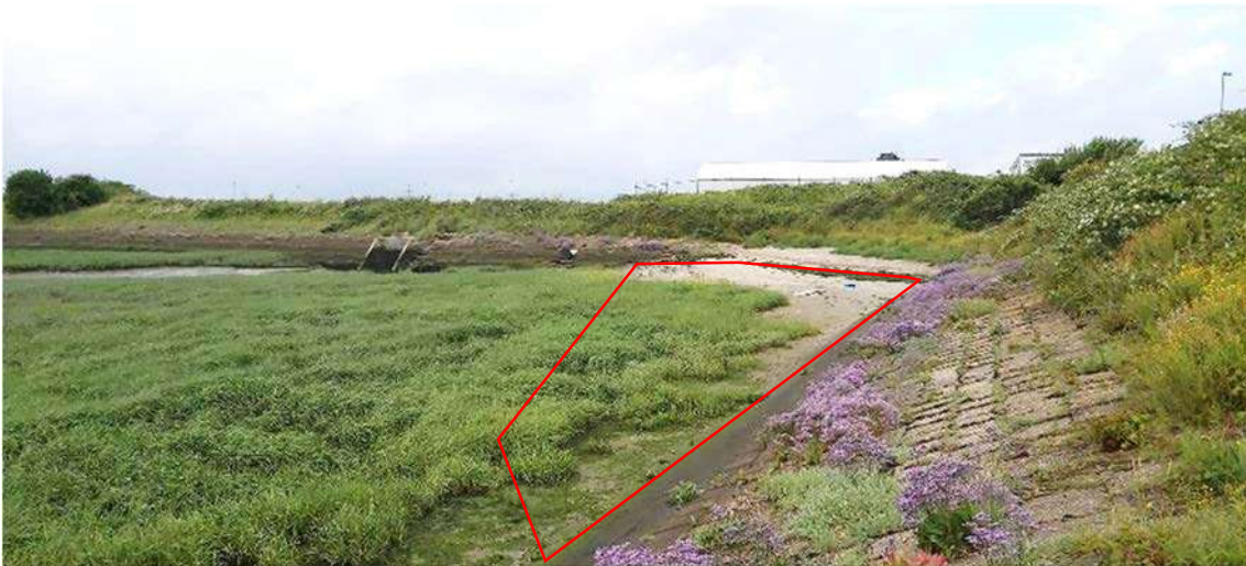
Figuur 6-8 Deel oostelijk overbelast hexagoon binnen Natura 2000 (foto K. Maas, Damen Shipyards, juli 2021)
