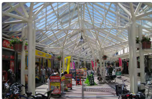
Project: luifel en uitstallingen Lange Zelke
