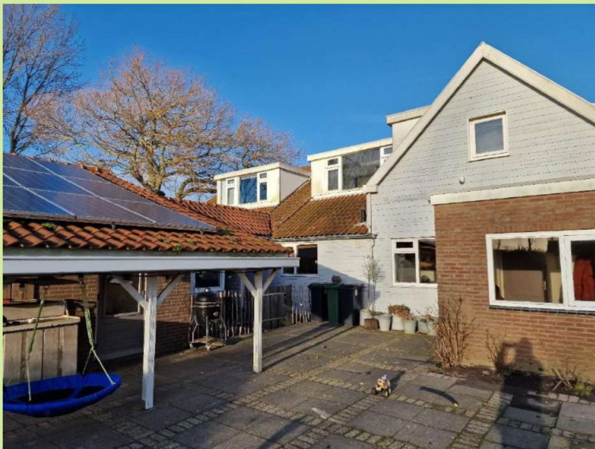
Figuur 12. Overzicht achterzijde.
