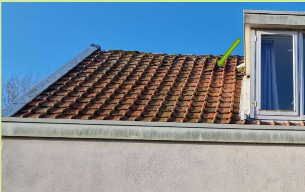
Figuur 4. woning achterzijde, Enkele dakpannen wijken ten opzichte van de overige pannen waardoor openingen ontstaan.
