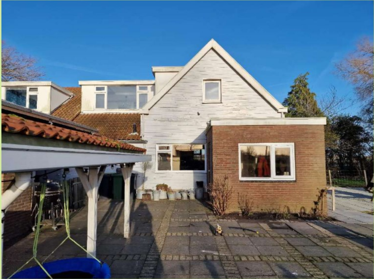
Figuur 11. Achterzijde woning, links een overkapping met daarachter de voormalige schuur.
