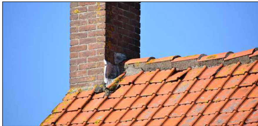
Figuur: op het dak van het woonhuis zijn losliggende of scheefgezakte dakpannen aanwezig waardoor vleermuizen, vogels zonder jaarrond beschermd nest en huismus ruimtes in het dak kunnen bereiken.
