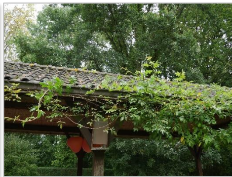
Te slopen aanbouw
