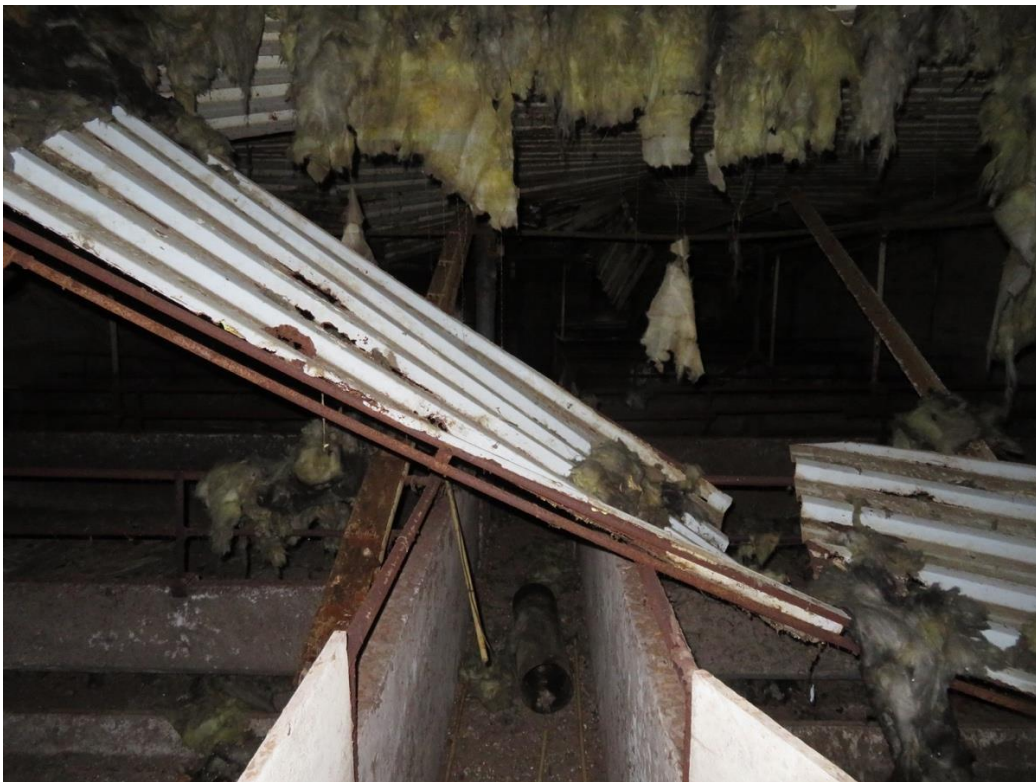
De toestand van de binnensituatie in gebouw(en) 3.
