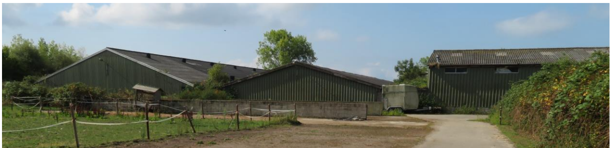
Daken verschillende gebouwen
