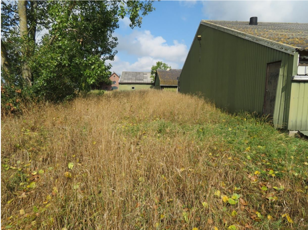
Daken verschillende gebouwen
