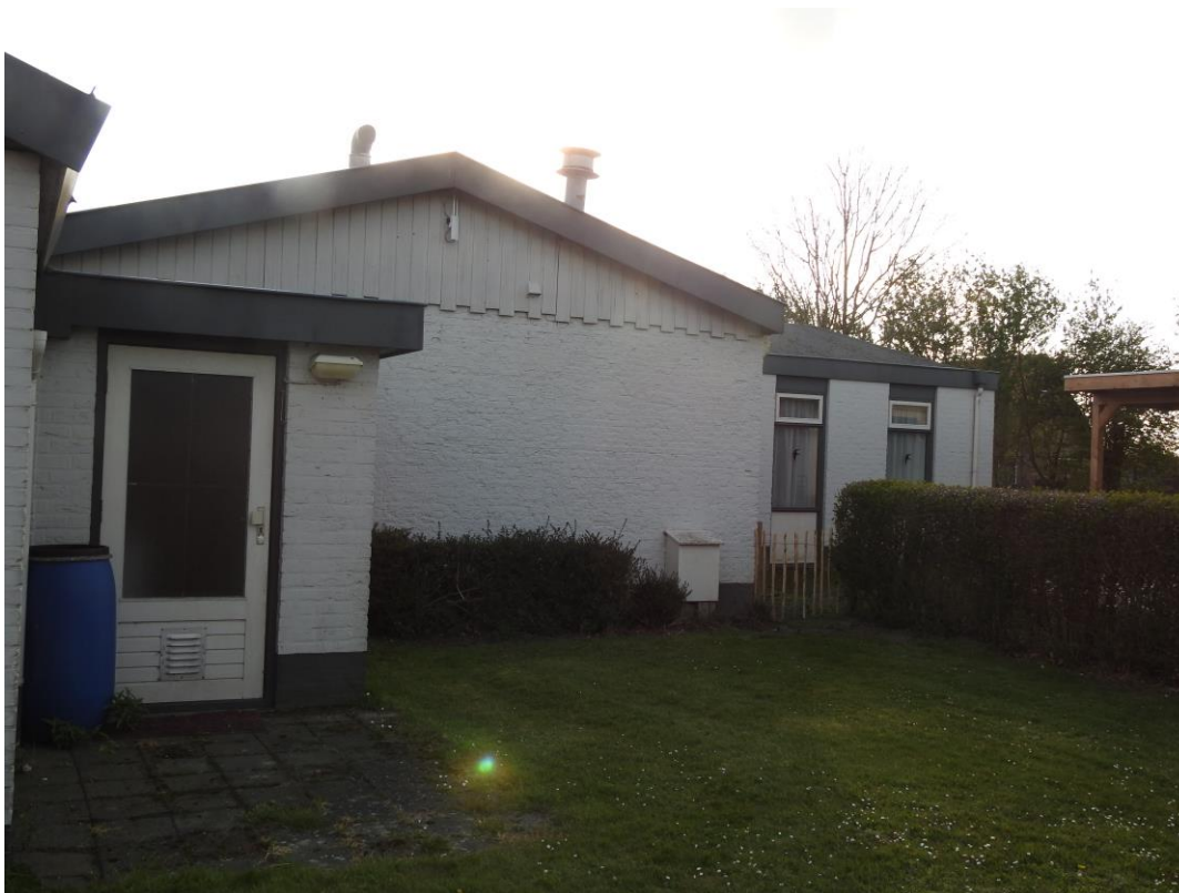
Foto 2. Plangebied, te slopen bebouwing.
