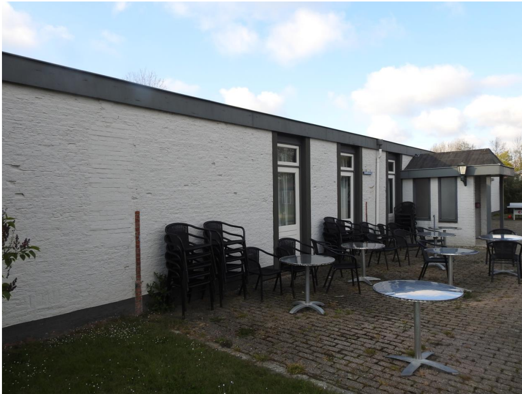
Foto 1. Plangebied, te slopen bebouwing.
