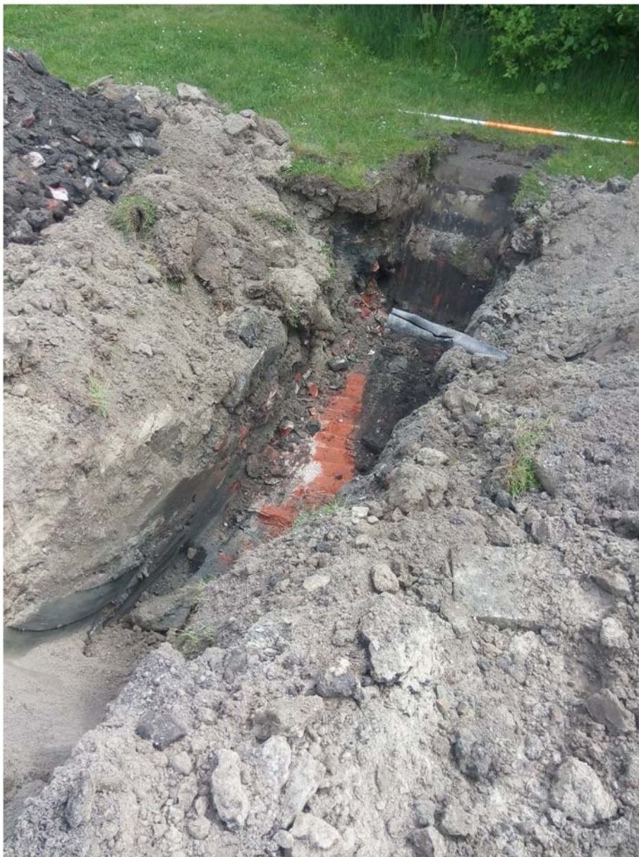
Sleuf SL03, baksteenfundering duidelijk zichtbaar.
