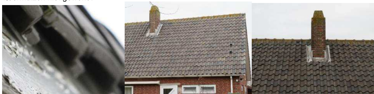
Afbeelding 6: Close-ups van kantpannen, dakpannen en loodslabben bij de schoorsteen.
