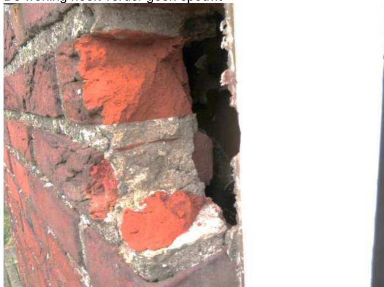
Afbeelding 7: open gebroken muur naast kunststof kozijn, Achter de muur vangt het rachelwerk met gips aan.
