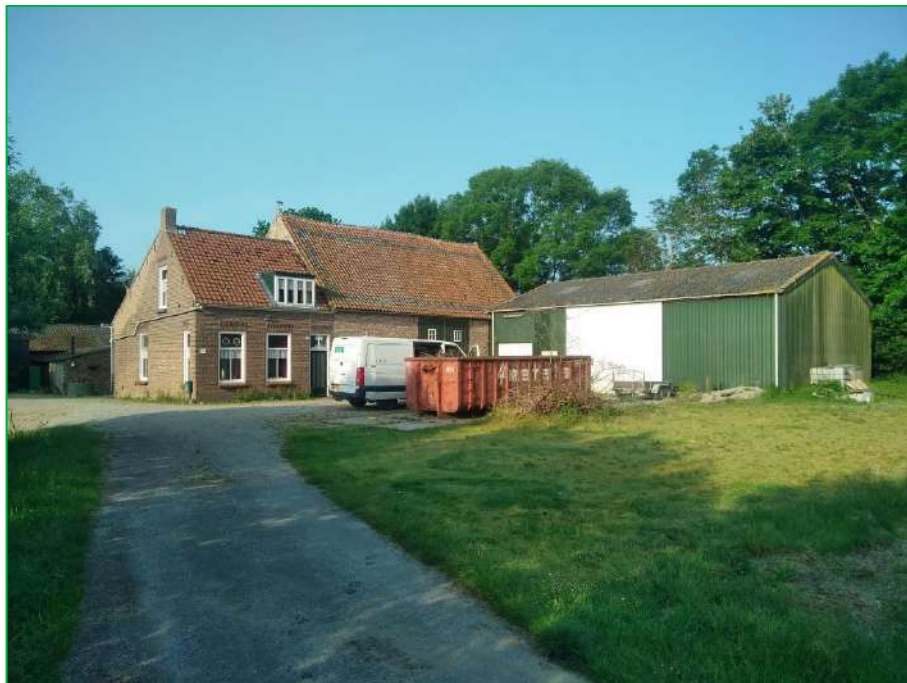
Foto 1. Ter hoogte van de container is de locatie van de nieuw te bouwen woning.
