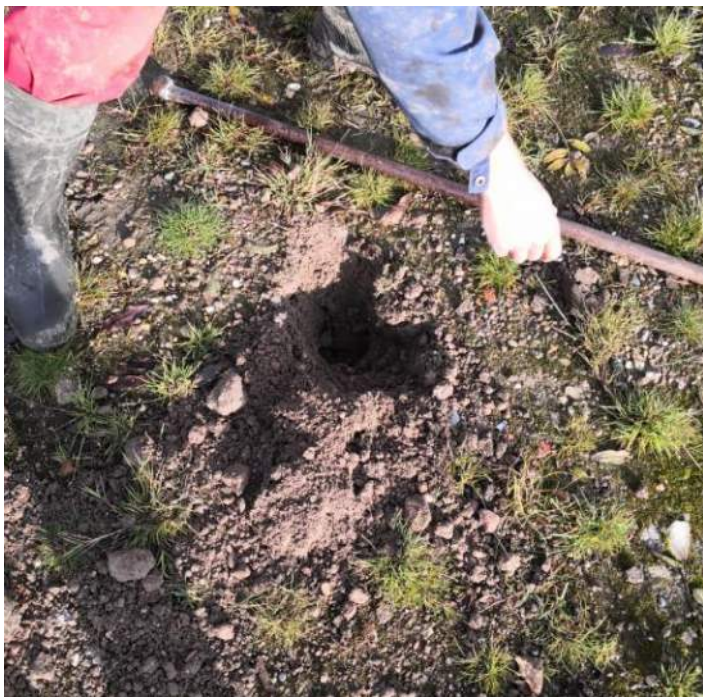
Foto 12: proefboring aan de zuid zijde van de puinverharding van circa 10 cm dik.
