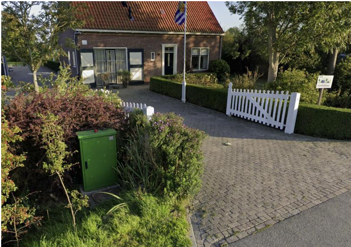
Figuur 4-2: Al aanwezige pompput gezien vanaf de straat
