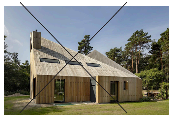
▲ geen schuurwoningen en afwijkende kapvormen
