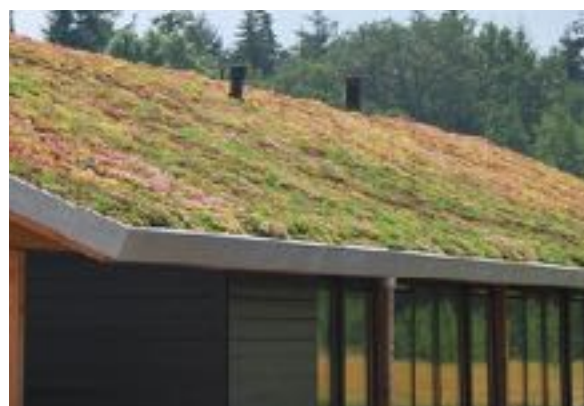
geïntegreerd vegetatie dak
