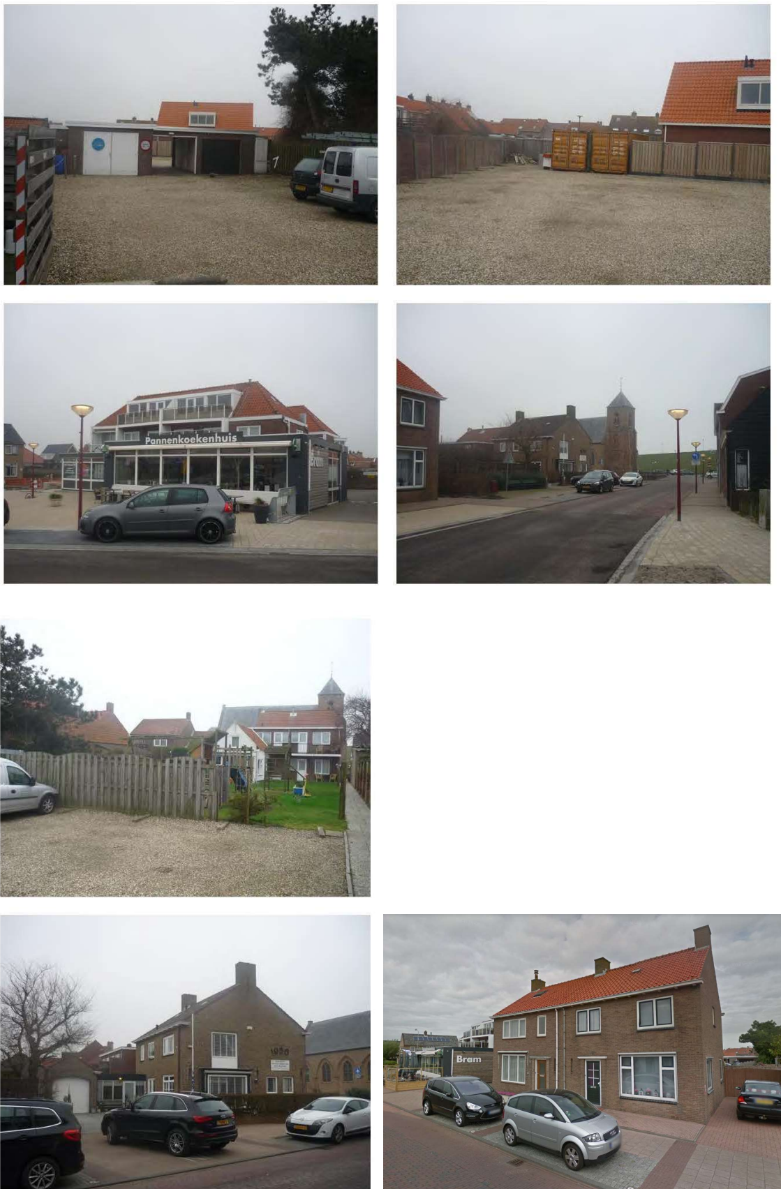
Figuur 4: Foto's bestaande situatie
