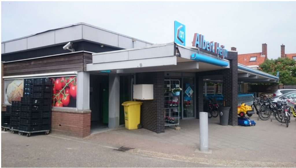
Figuur 1 De planlocatie supermarkt is gelegen aan de Singel 6te Domburg en bestaat uit een gemetselde, geïsoleerde spouwmuur met een plat, bitumen dak. De openstaande daklijst (linksboven op de foto) is (m.b.v. lamp) gecontroleerd op de aanwezigheid van kieren of openingen die vleermuizen mogelijk toegang zouden kunnen verlenen, dit bleek niet mogelijk te zijn.
