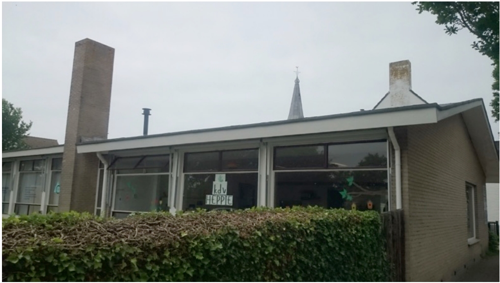
Figuur 3 De planlocatie fysiotherapeut/kinderdagverblijf is gelegen aan de Zuidstraat 14 te Domburg. Het gebouw bestaat uit gemetselde, geïsoleerde spouwmuren en een bitumen zadeldak met overstek.
