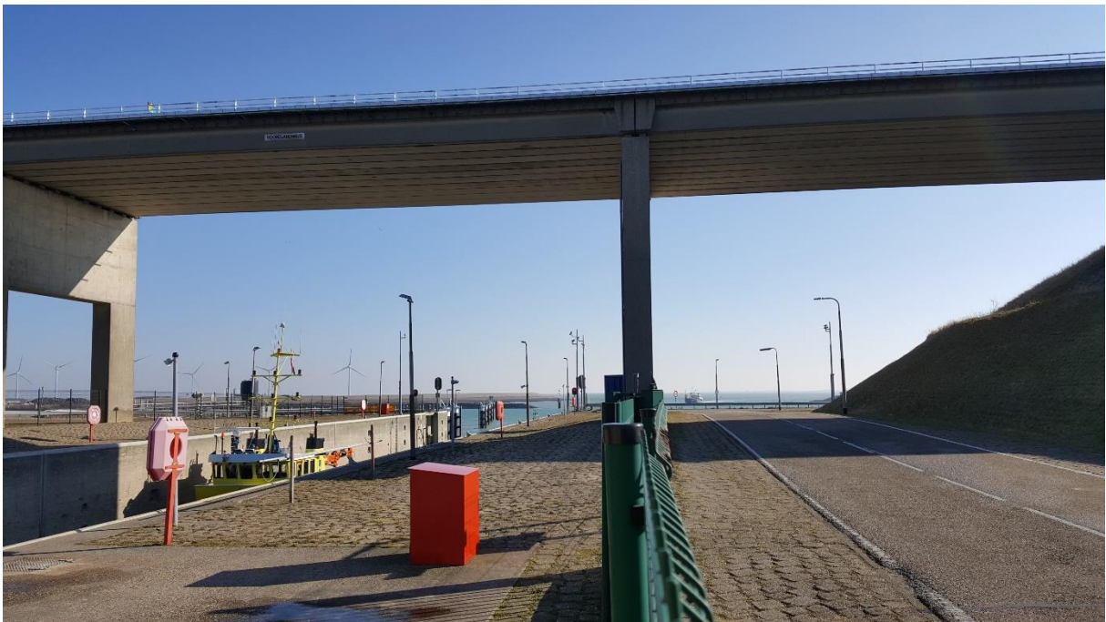
Figuur 6: Noordlandbrug (foto vanuit de positie van de radar, maaiveld niveau)
