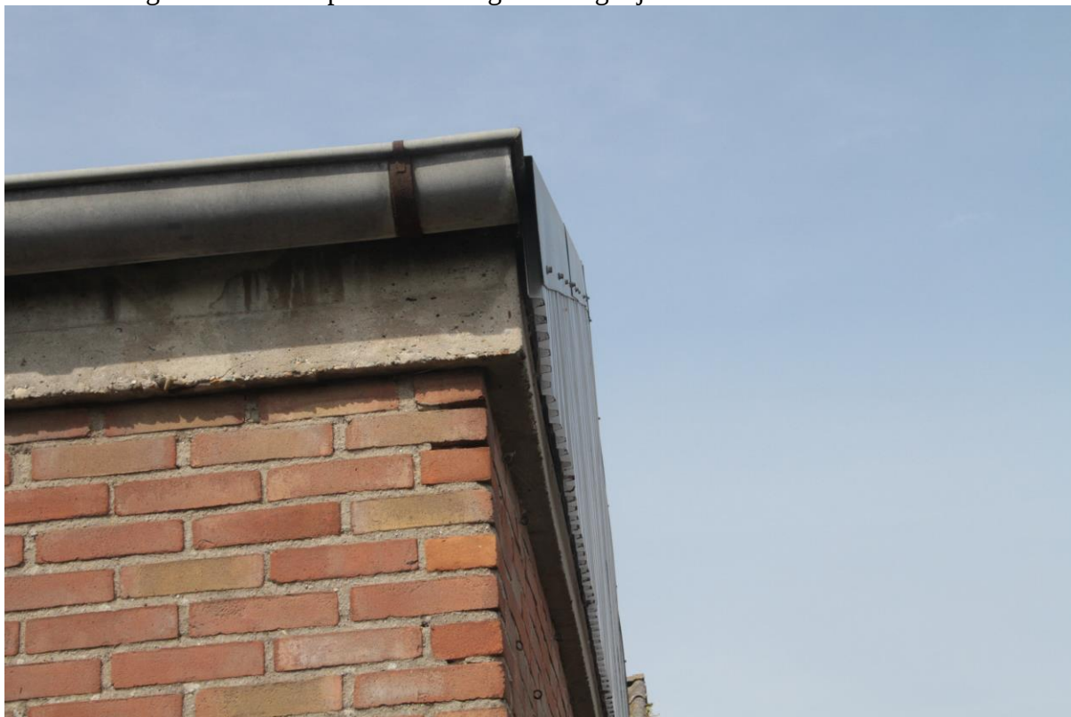
Foto 9. Deelgebied 3. Te slopen bebouwing met mogelijkheden voor vleermuizen.
