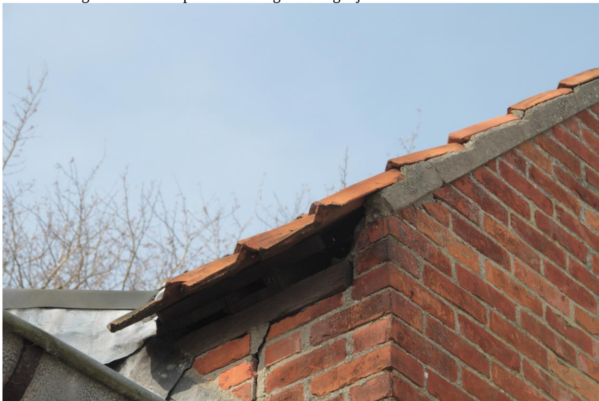
Foto 8. Deelgebied 3. Te slopen bebouwing met mogelijkheden voor vleermuizen.
