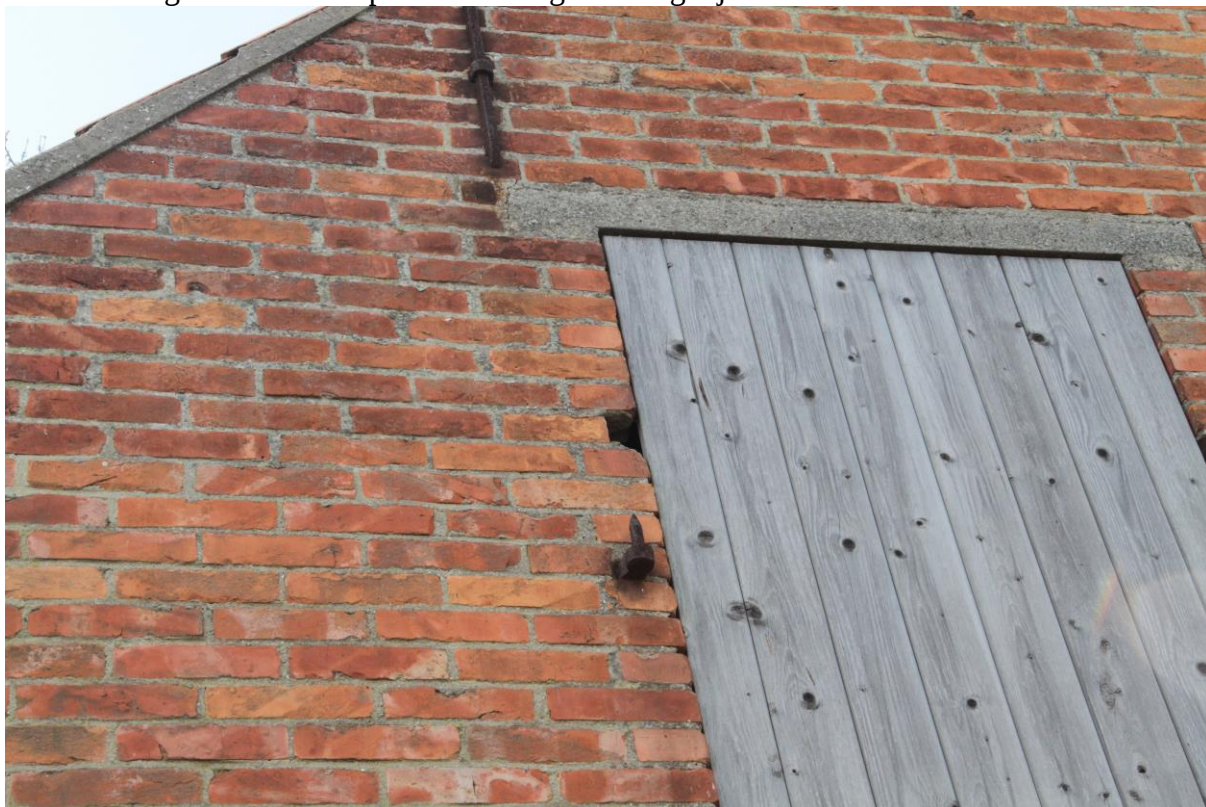
Foto 7. Deelgebied 3. Te slopen bebouwing met mogelijkheden voor vleermuizen.
