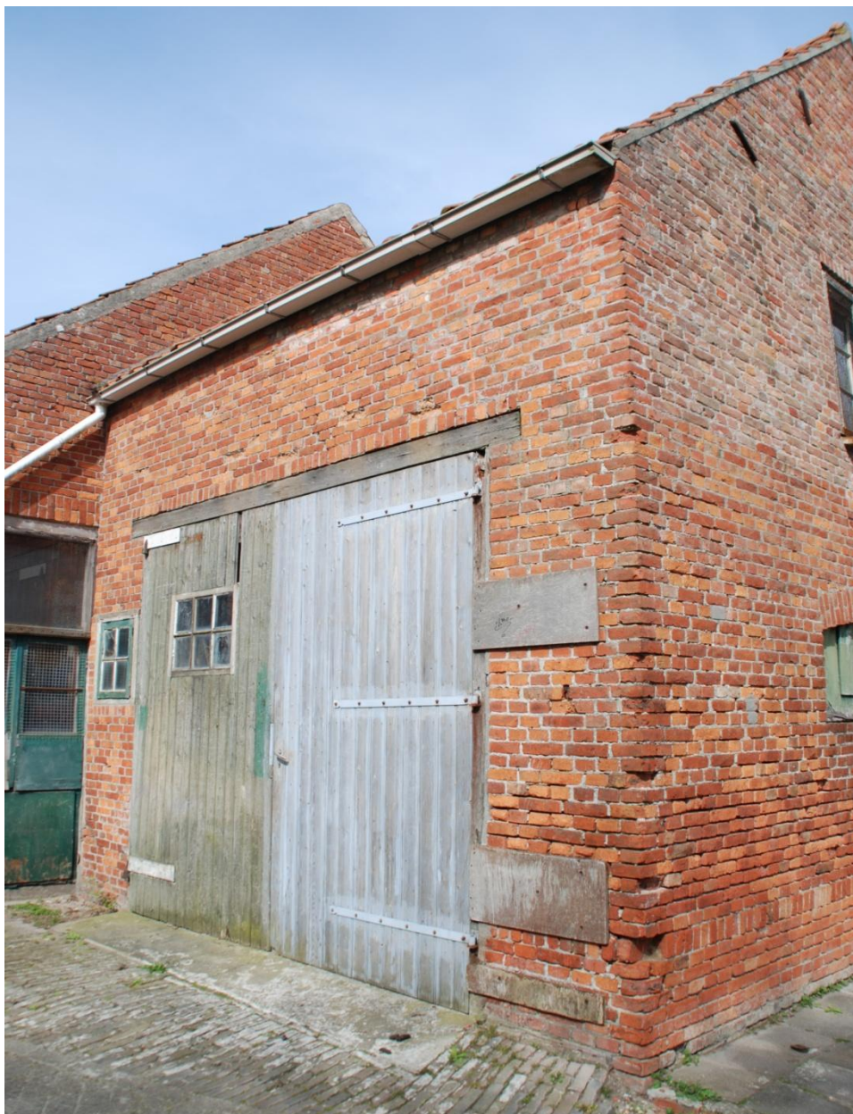
Afbeelding 14 : De gevel aan de Nijverheidsweg.
