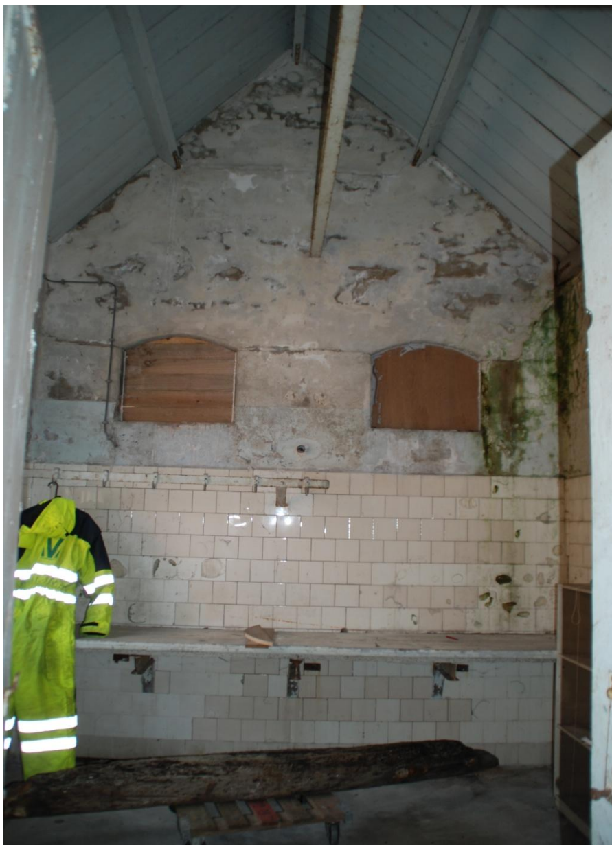
Afbeelding 8 : De achtergevel vanuit de binnenzijde.
