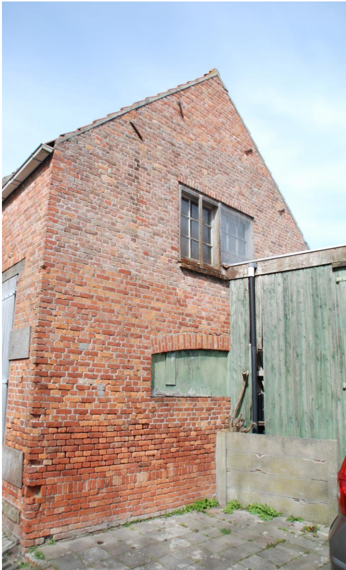
Afbeelding15 : De achtergevel van de aanbouw.
