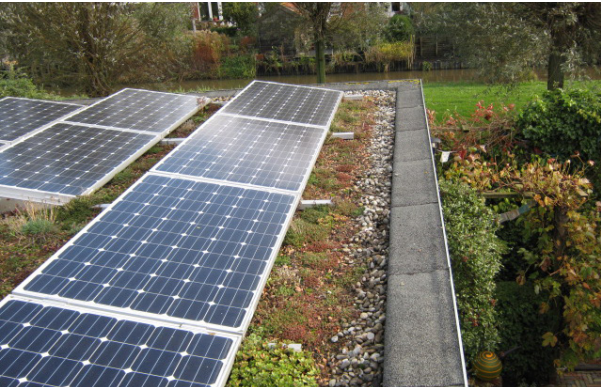
Zonnepanelen in een groendak ▲
